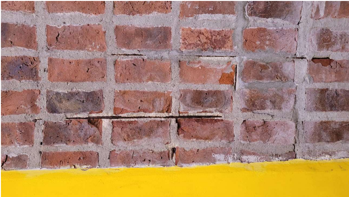
Fotografía de hierros a la vista, patología encontrada principalmente en el interior de las bóvedas
